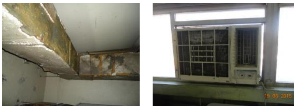
Figura 13. Fotos de falhas no isolamento de dutos de ar condicionado e na vedação na instalação de ACJ. Fonte: Mitsidi, 2015.
