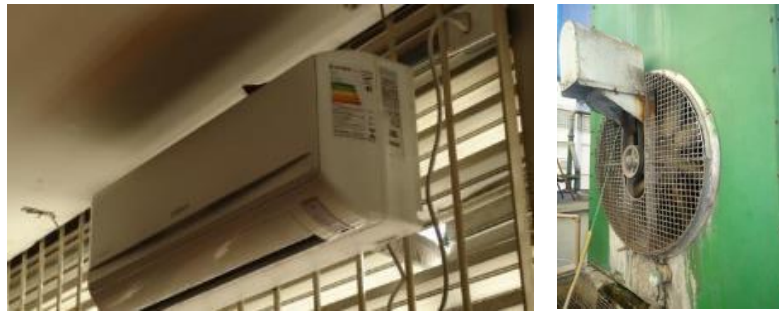
Figura 15. Exemplo de split e ventilador da torre de resfriamento. FONTE: Mitsidi, 2015.
