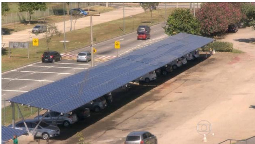
Figura 31. Foto do primeiro estacionamento solar na UFRJ 10 .
