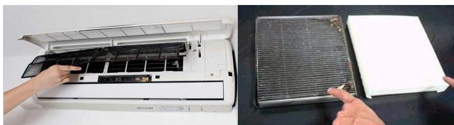
Figura 11. Troca de filtro de split e comparação de filtro velho e novo 3 .
