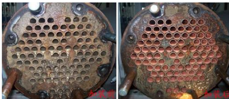
Figura 12. Condensador de um chiller a água, obstruído (esquerda) e livre (direita), demonstrando a importância de realizar o tratamento da água das torres de resfriamento 4 .
