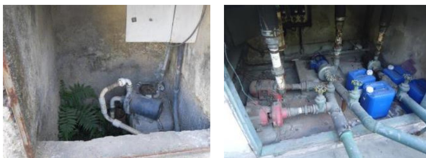
Figura 18. Fotos de bombas de água encontrados nas visitas técnicas. FONTE: Mitsidi, 2015.
