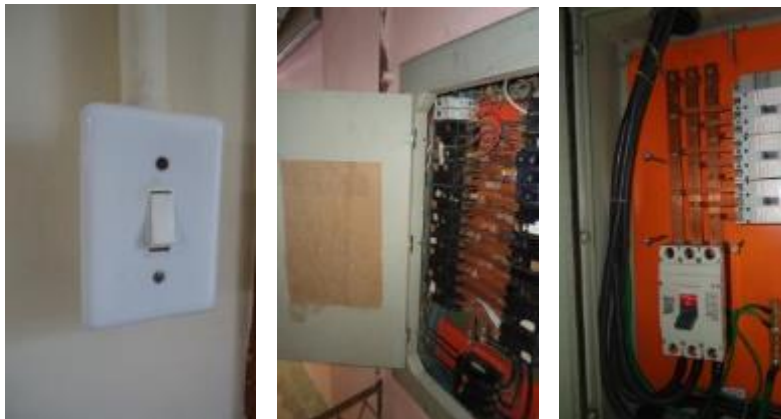
Figura 24. Necessidade de instalação de interruptores e reformas de painéis de disjuntores. Fonte: Mitsidi, 2015.
