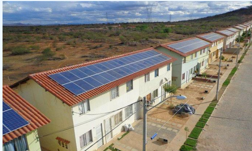
Figura 39 - Foto da microusina solar de Juazeiro, BA (Fontes: CAIXA, 2015)
