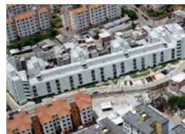
1. Gleba A, Conjunto Habitacional finalizado em 2007
