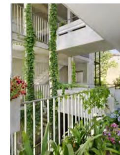
Acesso aberto às escadas centrais
