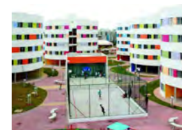
2. Gleba A, Conjunto Habitacional finalizado em 2007.
