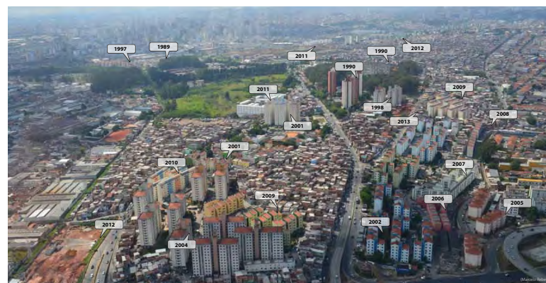
Vista aérea de Heliópolis a partir da área Nordeste ilustrando as intervenções da COHAB
